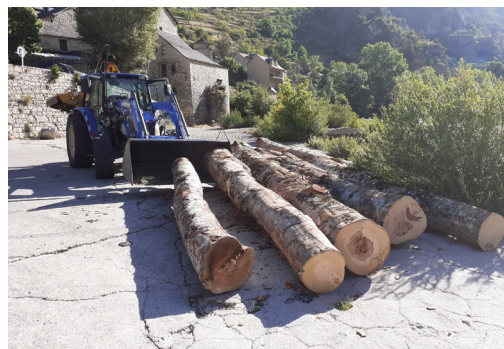
Aménagement parking à Sainte-Enimie
