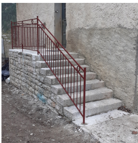
RAMPE D'ESCALIER À L'ANCIENNE ÉCOLE DE MONTBRUN
