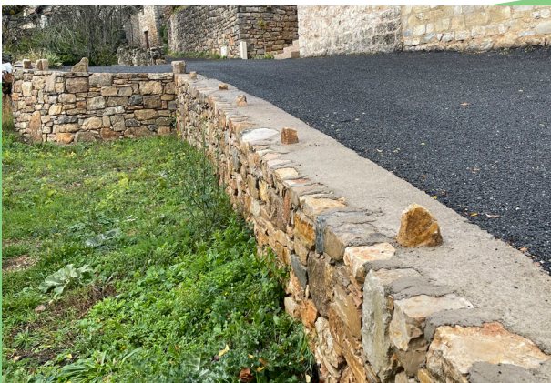
MUR DE SOUTÈNEMENT A POUJOLS DE BLAJOUX
