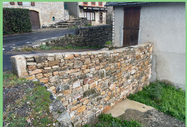
MUR DE SOUTÈNEMENT A PRADES
